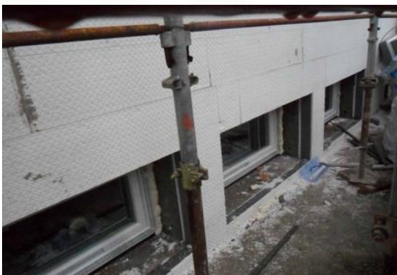
Dettaglio coibentazione
